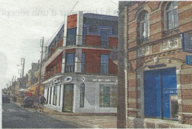
La future agence postale rehaussée de quatre logements
