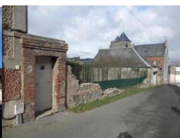
Mur démoli rue de la Mer
