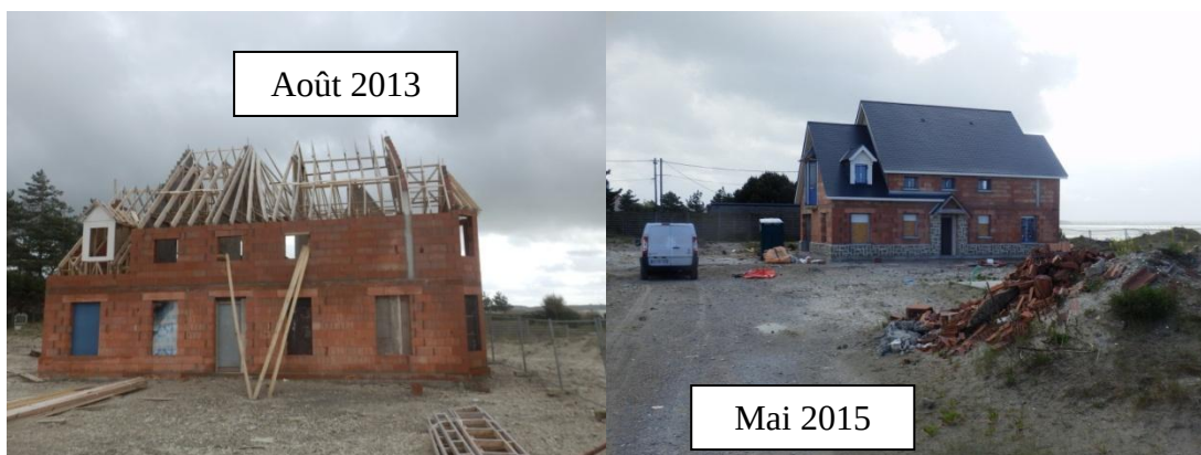
Photo de la 1ère villa. Les cinq autres villas ne sont pas commencées Le reste du chantier est un « terrain vague »
